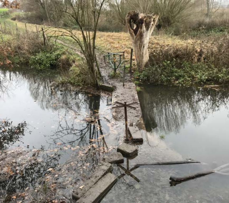
Figuur 8 Een Bever ( Castor fiber ) heeft middels het bouwen van een dam bij het dorp Eys het waterpeil met meer dan een meter verhoogd. Een wandelpad staat onder water. De snelstromende beek is veranderd in een stuwpannd met vrijwel stilstaand water (foto: R. Gubbels).
